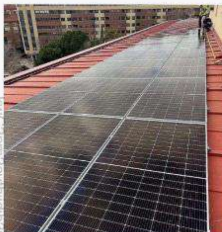
Trabajos de instalación de las placas solares en la cubierta del centro. COCEMFE
