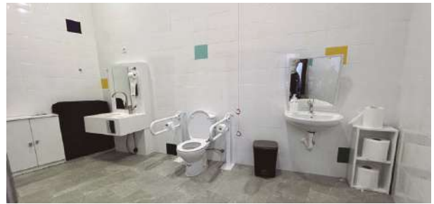
Obras de Mejora de rehabilitación Stand de Feria y un nuevo baño adaptado.
